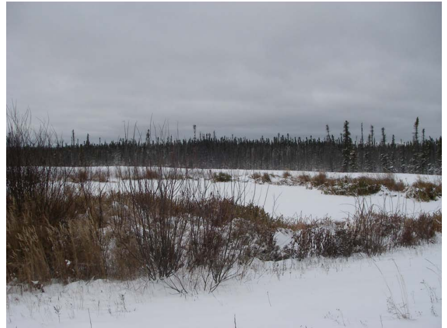
Edzo Sewage Sludge Cell
